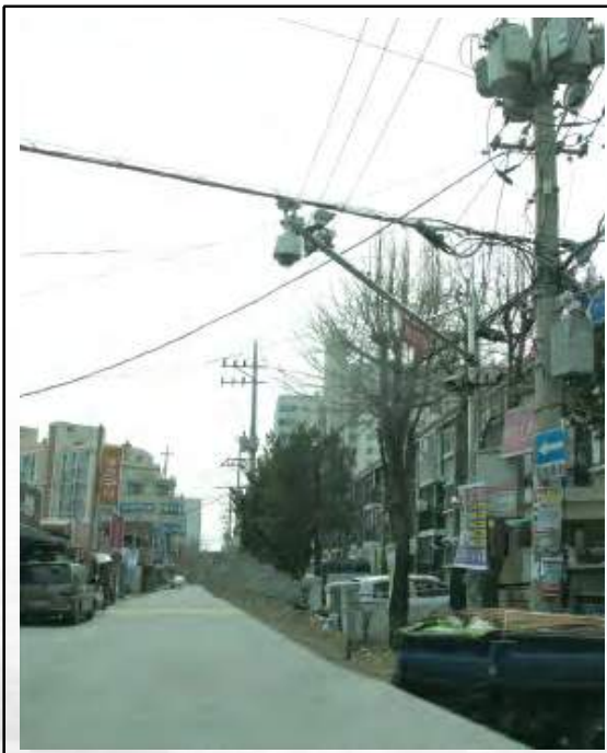
< 그림V-46 인식이 어려운 CCTV 설치 사례 >
