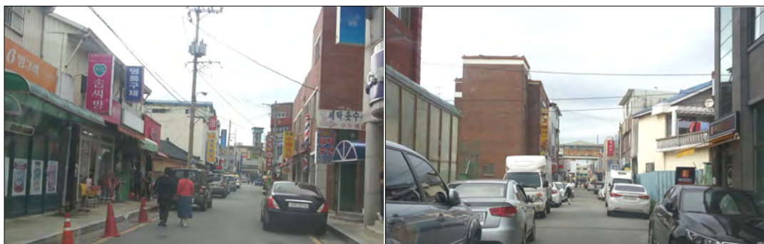
(그림4-18) 지구내 8m도로 현황(불법주정차 및 보행공간 미확보)
