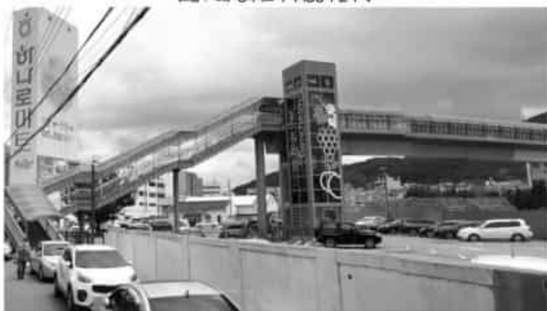
〈그림 7-28〉 평화육교 수직이동장치 설치 예
