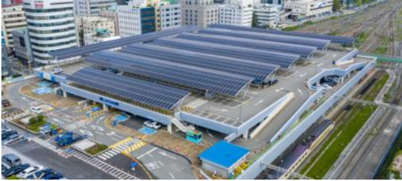
〈주차장 태양광 발전시설(부산)〉
