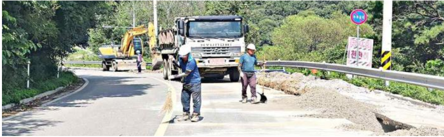
〈 신니면 회문마을 상·하수도 관로 매설작업 〉
