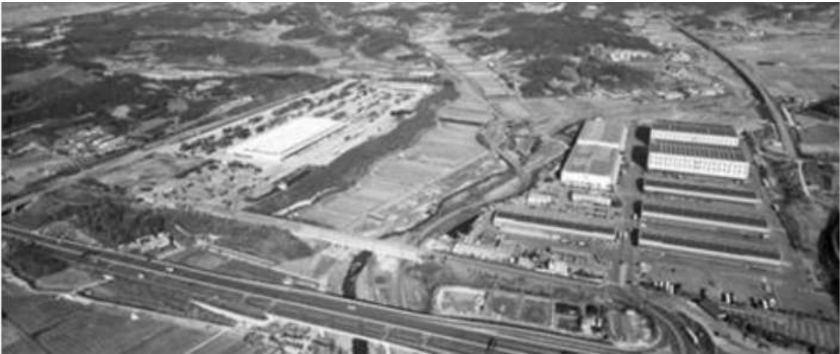
[그림 3-2-39] 중부 내륙물류기지 전경
