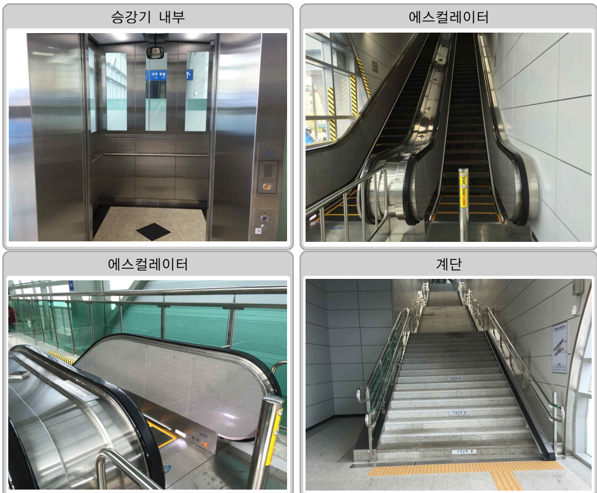
〈그림 4-23〉 도시철도 역사 수직이동시설의 이동편의시설 조사사진
