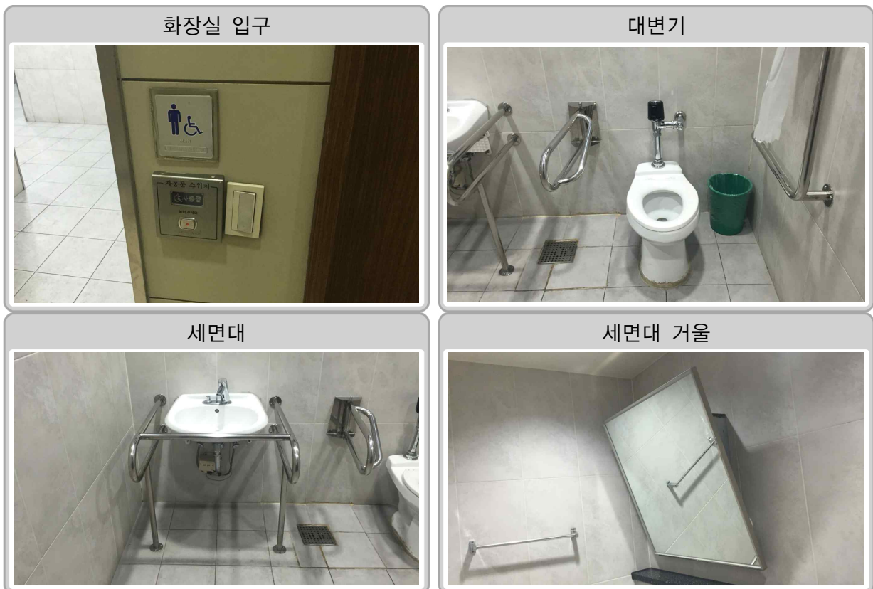
<그림 4-12> 여객자동차터미널 장애인전용화장실 이동편의시설 조사사진
