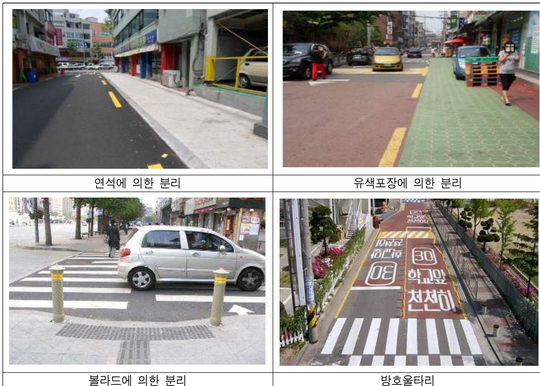
< 그림 5 - 33 > 보행자·차량 분리 시설 설치 사례
