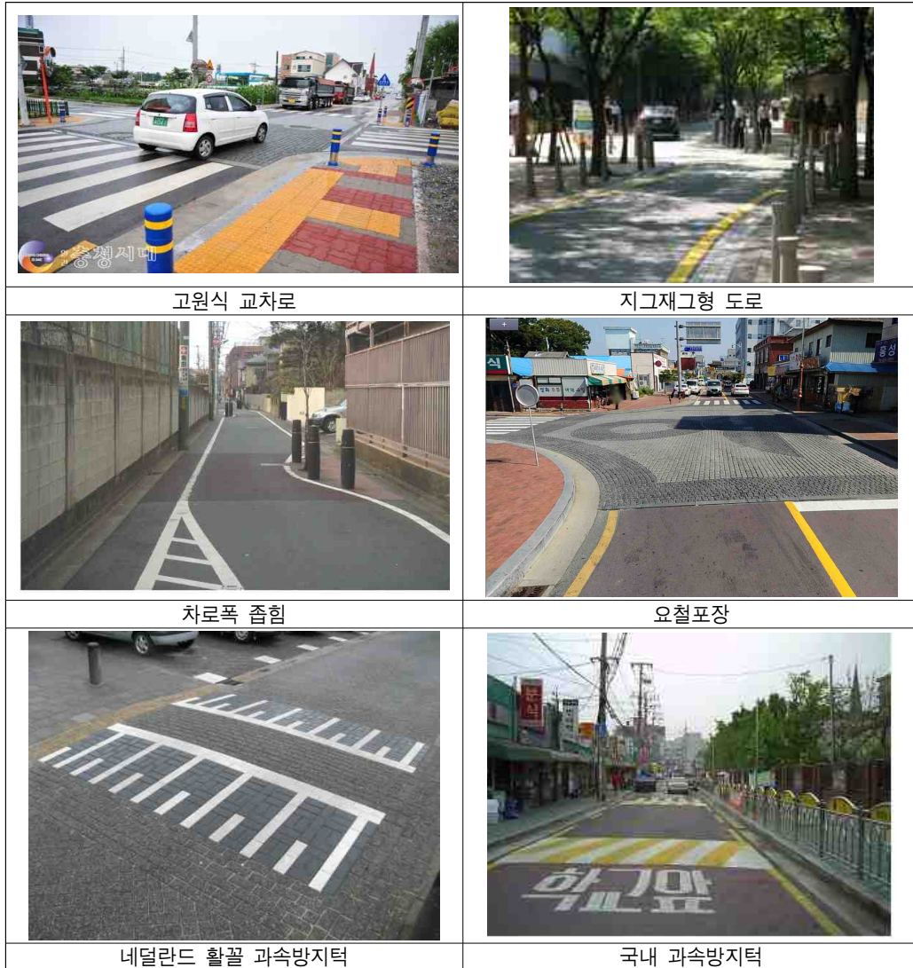
<그림 5-24> 속도저감 시설 설치 사례
