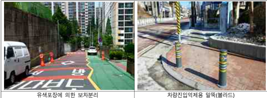
유색포장에 의한 보차분리 및 차량진입억제용 말뚝(볼라드) 사례 <그림 5-7> 유색포장에 의한 보차분리 및 차량진입억제용 말뚝(볼라드) 사례
