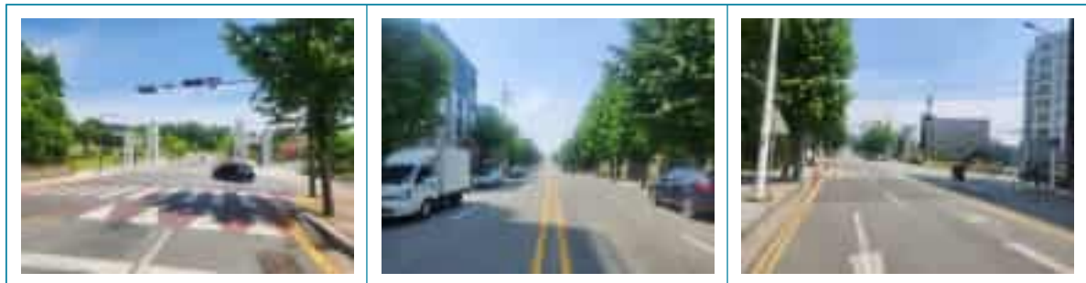
&lt;그림 4-26&gt; 조치원읍 고려대 정문교차로 ~ 세종여고교차로 현황
