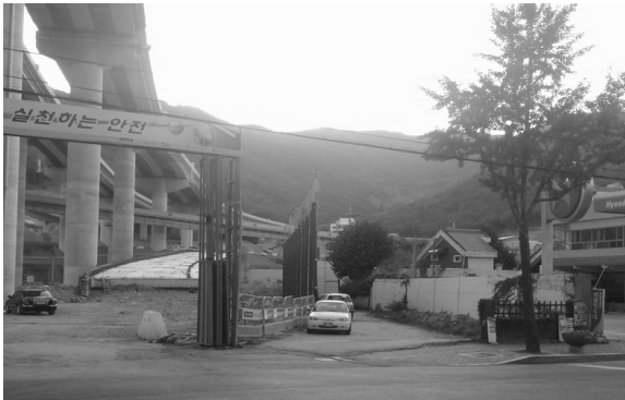
고가도로 설치로 인한 주변 불량(수성구 파동 일원)
