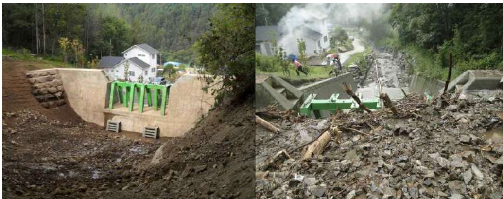
생활권 사방댐 설치 전·후 비교를 통한 설치효과 분석(춘천시 서면 오월리)
