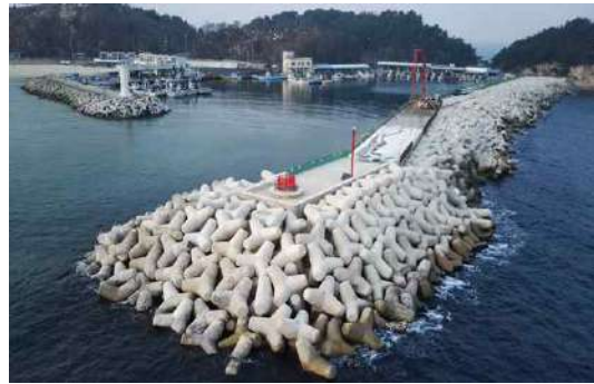
지방 어항 방파제(보강 후)
