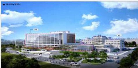
원주의료원(서관증축 및 별관 리모델링)
