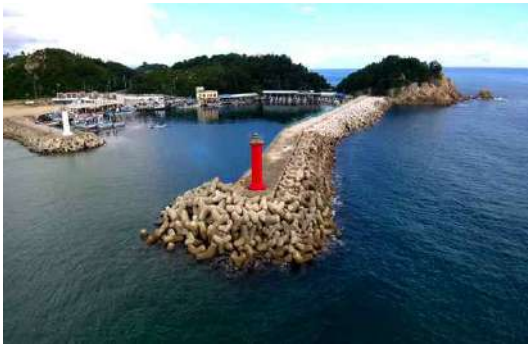
지방 어항 방파제(보강 전)
