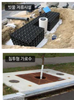
저류조 및 침투시설 설치
