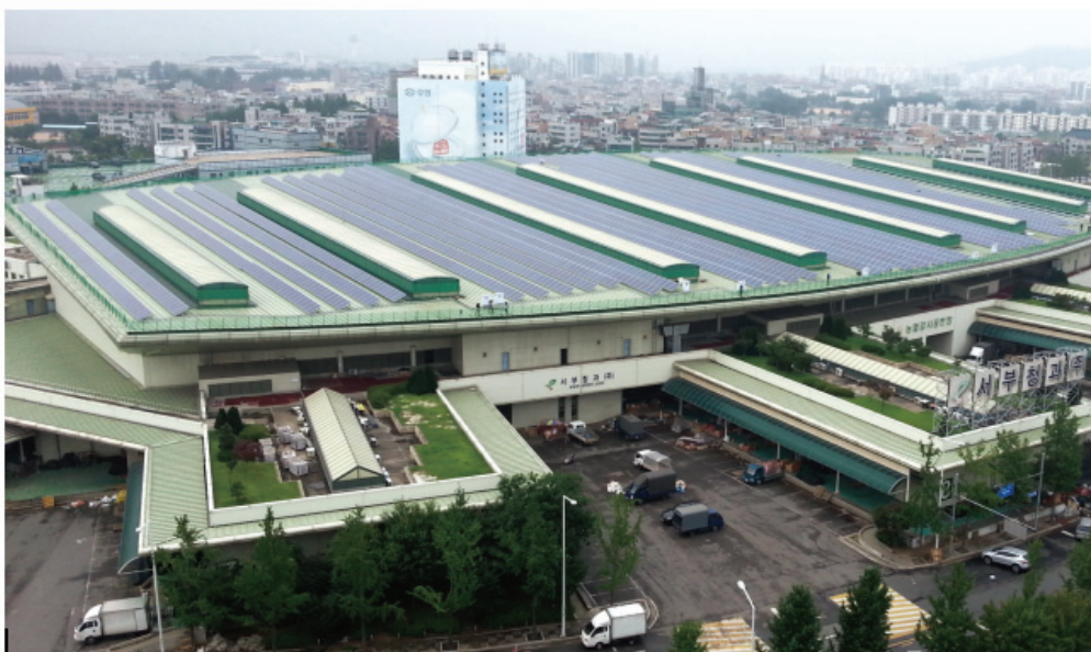
〔그림 2-11〕 강서농수산물시장 옥상에 설치된 태양광 사례
