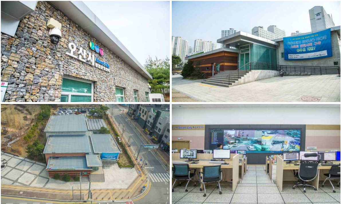
[그림 2-2-5] 오산시 스마트시티 통합운영센터 전경 및 내부(관제실) 사진
