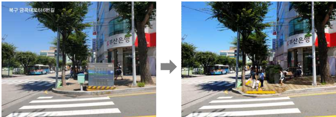
[그림 5-16] 턱낮춤 및 점자블록 개선 예시
